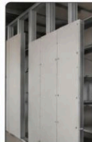
METAL STUD FRAMING
